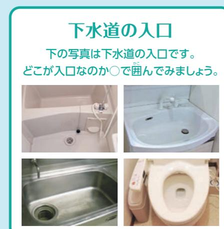
家や庭の下には、よごれた水や雨水を流す管(はい水管)がうめられています。はい水管は、道路の下にある下水管管につながっています。はい水管は熱に弱いので熱湯を流さないようにしましょう。
